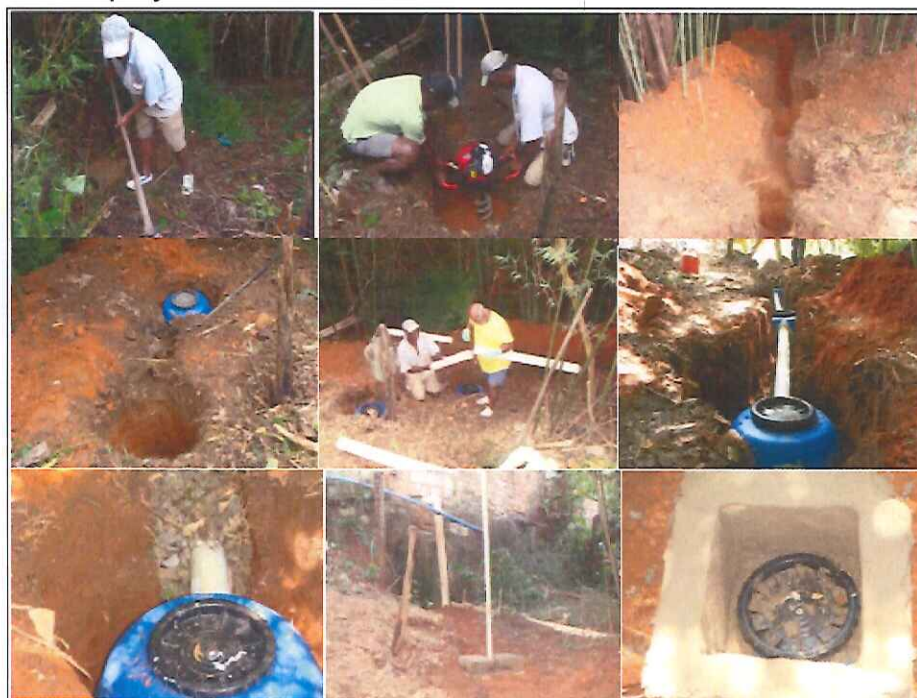
Figura 1 - Sequência de instalação do módulo demonstrativo da fossa séptica
